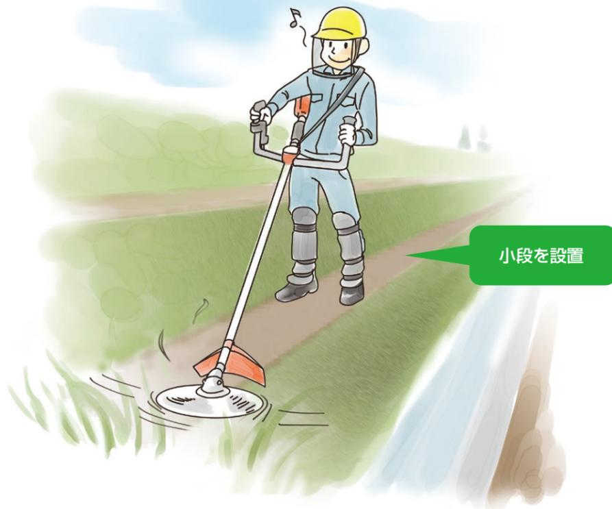
傾斜面・法面に小段の設置、スパイク靴の着用
